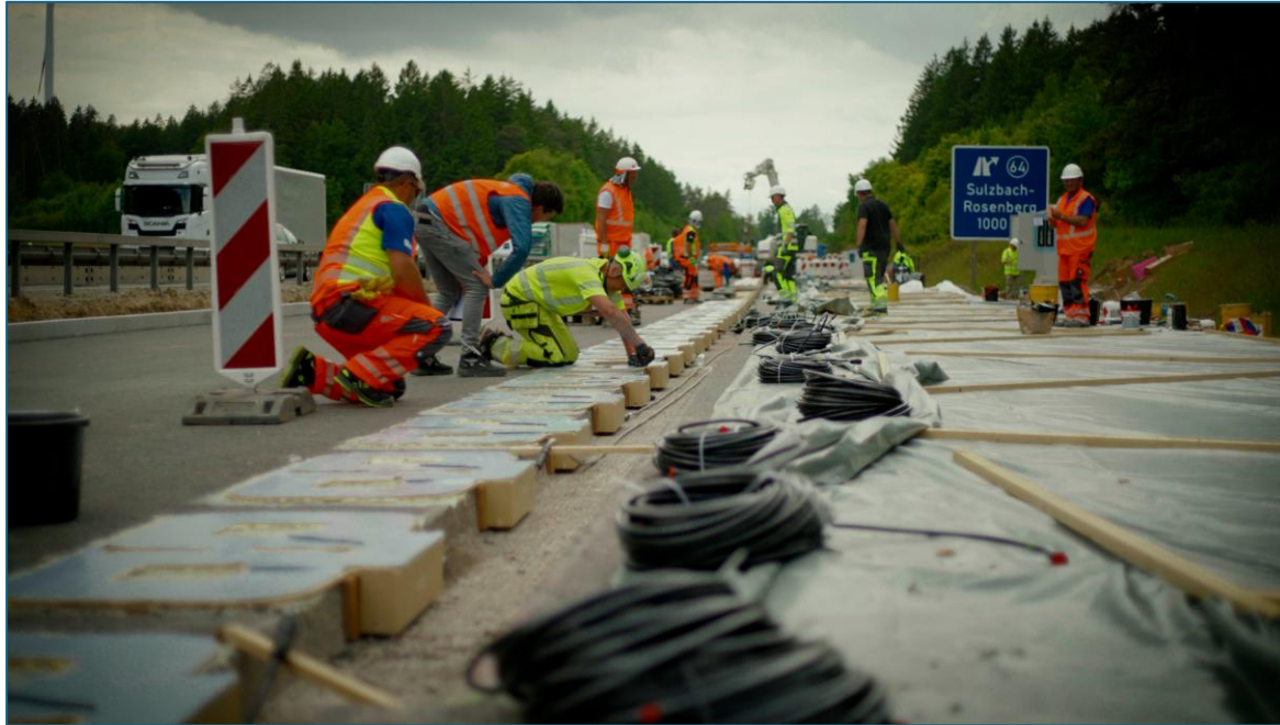
A6 D 829L, Fahrbahnerneuerung + FE – E|MPower (dynamisches induktives Laden)
