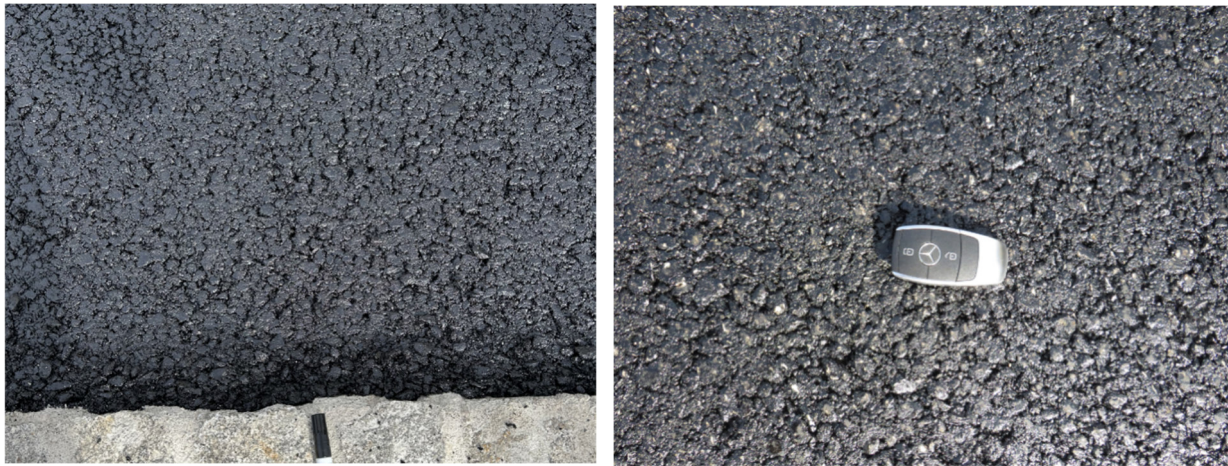
Abbildung 26: Oberflächenstruktur des eingebauten und verdichteten AC 16 B SG, Referenzstrecke (links) und VB-Strecke (rechts)
