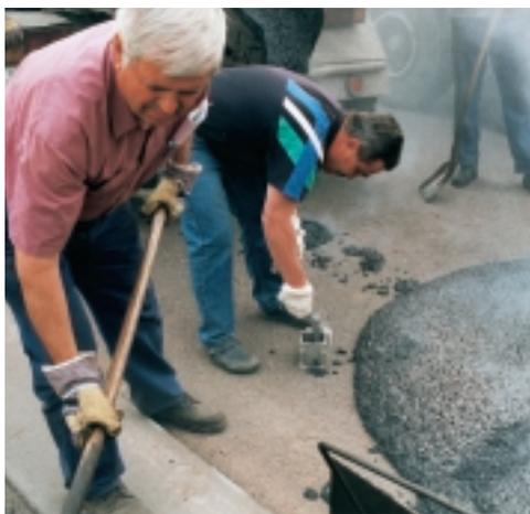
Entnahme einer Gußasphaltprobe auf der Baustelle
