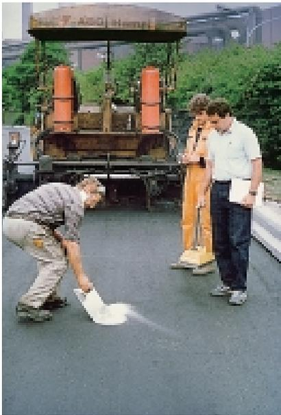
Messung der Raumdichte hinter dem Fertiger
