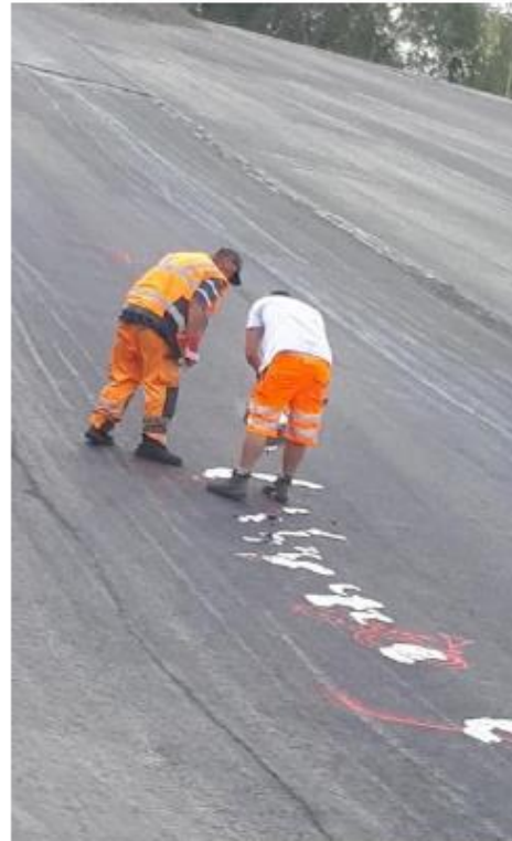
Sanierung: Verguss mit Heißbitumen
