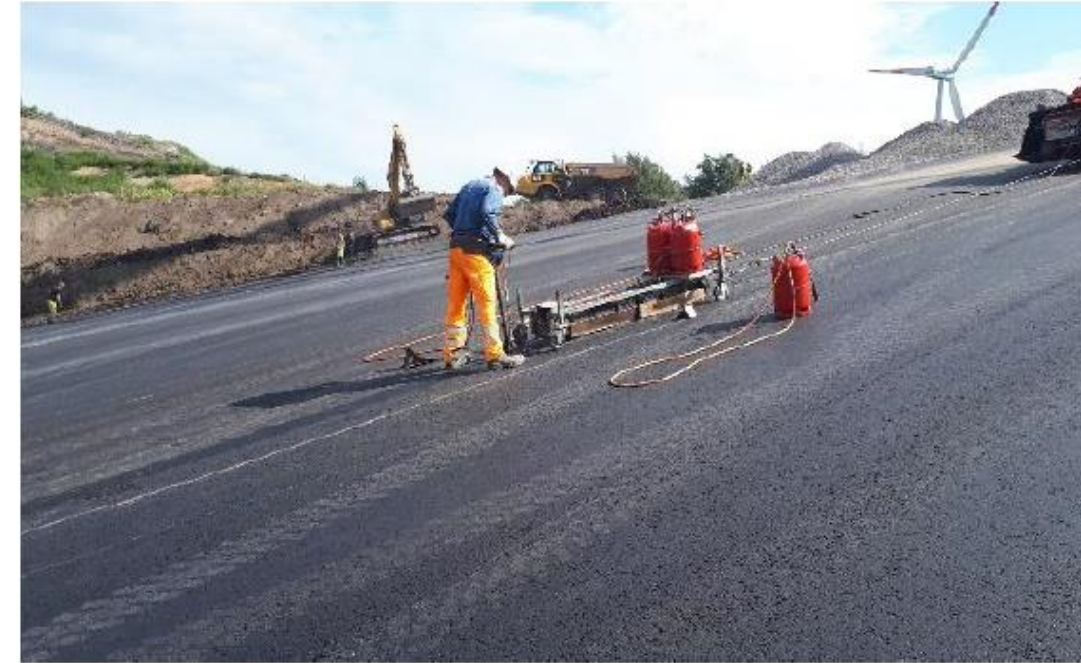
Nachbehandlung: mittels Infrarotleiste und Vibrationsstampfer
