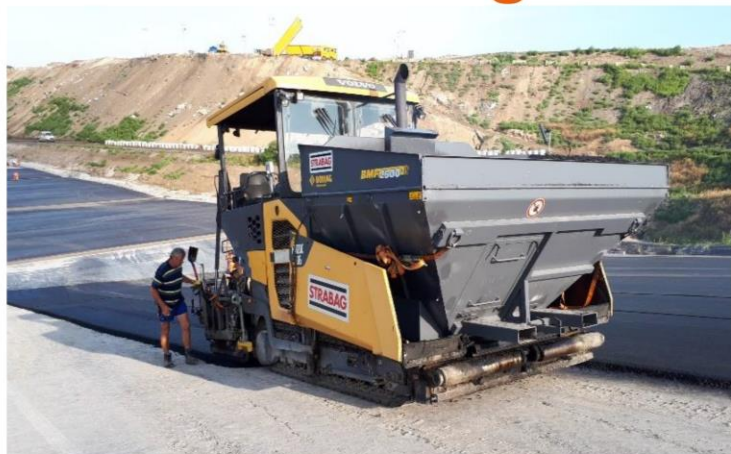
Fertigereinsatz Böschung 1:4
