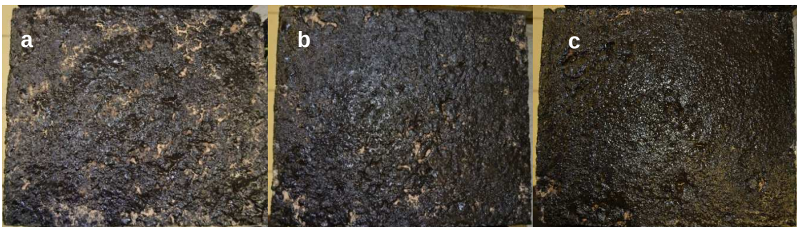
Abbildung 5.53: Stark verschmutzte Oberfläche mit aufgetragener Bitumenemulsion (a - 200 g/m 2 , b - 300 g/m 2 , c - 400 g/m 2 )
