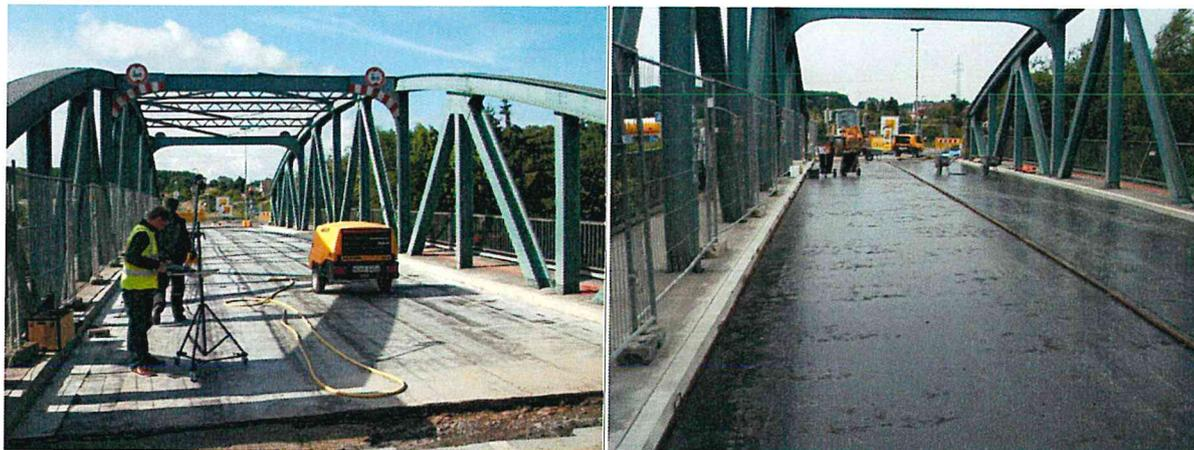
Abbildung 49. Bitumenschweißbahn (links) und Gussasphaltschutzschicht (rechts).
