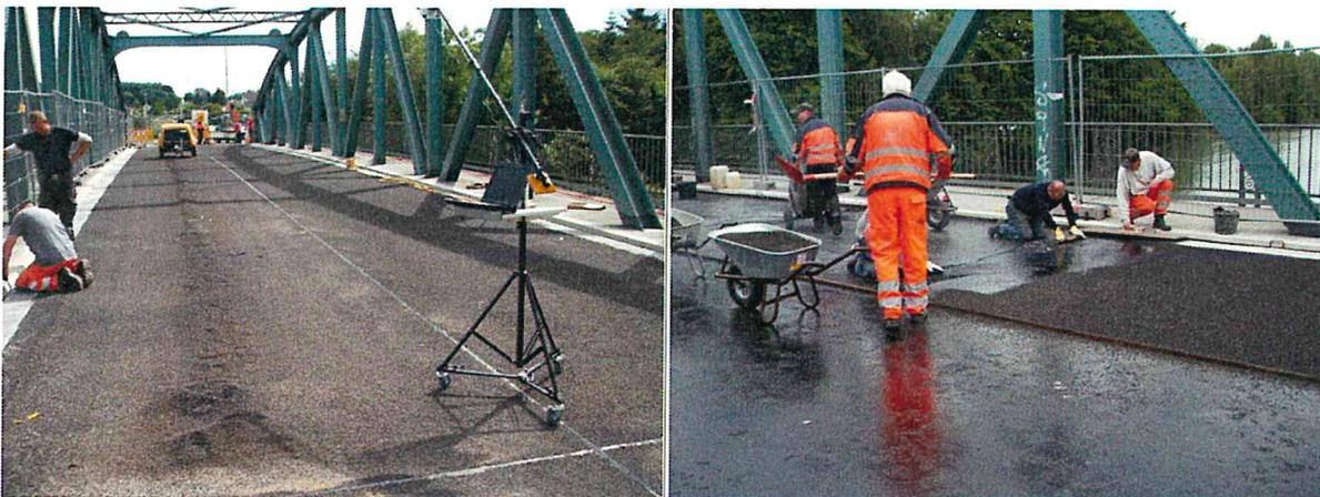
Abbildung 52. Gussasphaltdeckenschicht (links) und Gussasphaltdeckenschicht (rechts).
