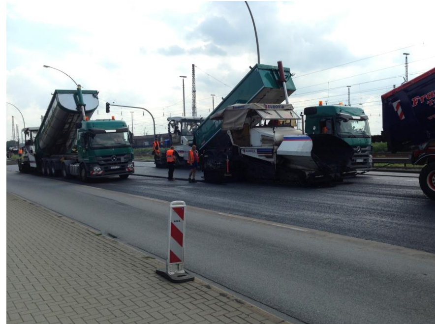
Versuchsstrecke Veddeler Damm Haupthafenroute SMA 8 s mit max. Ausbauasphalt
