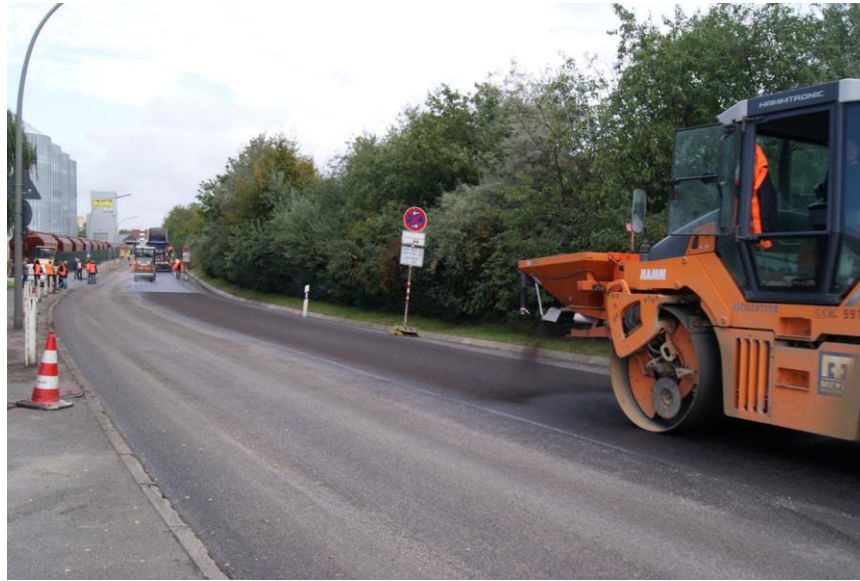
Versuchsstrecke Pollhornweg AC 11D S mit max. Ausbauasphalt
