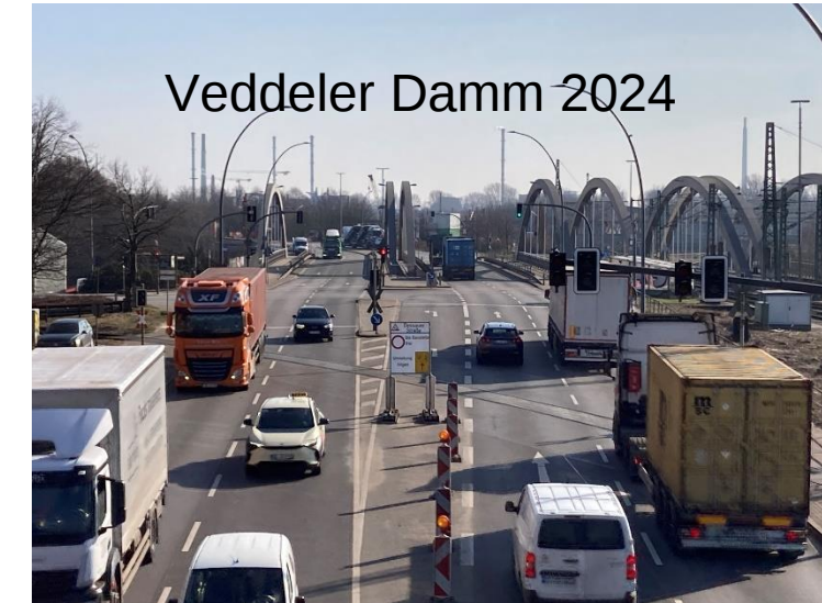
Veddeler Damm Erneuerung 2024
