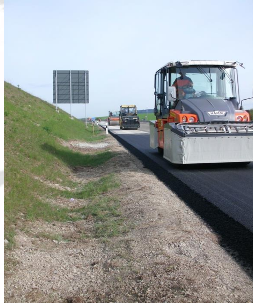
BAB A73 Eisfeld RF Coburg Standspur GRW und die beiden Glattmantelwalzen beim Verdichten
