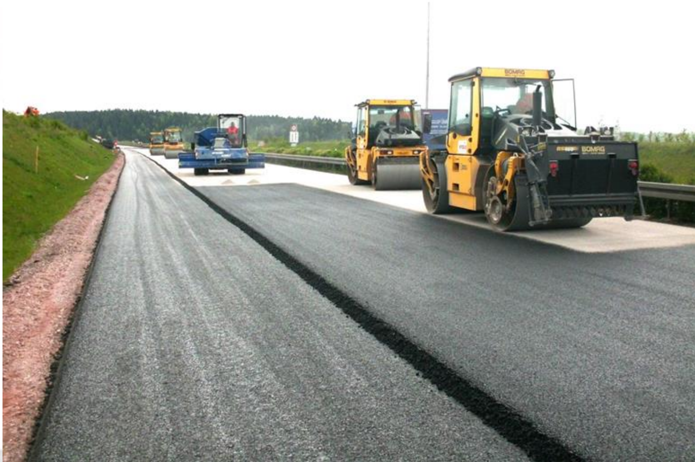
BAB A73 Eisfeld RF Suhl Beobachtungstrecke (Last- und Überholspur) Linienstreuer mit 4 Glattmantelwalzen zum Endverdichten
