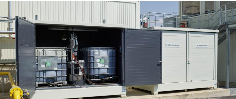
Zugabesystem flüssige Additive
