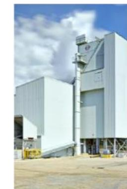
Bitumendämpfe (Blue Smoke) sind neben C<sub>ges</sub>, NOx, SOx sowie anderen schwefelhaltigen Verbindungen die Hauptgeruchsquelle.
